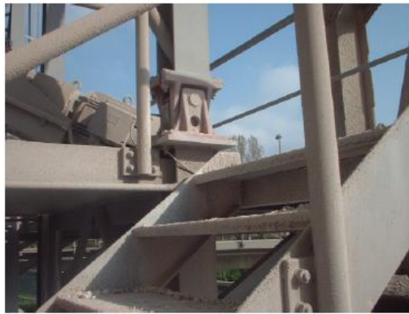
Figuur 10 – voorbeelden van T95 loadcells geïnstalleerd onder silo's en tanks
